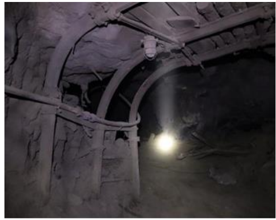
4-сурет. а - Штрек көлденең қимасының деформациясы, б - Бекіткіштің деформациясы
