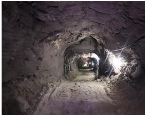
4-сурет. а - Штрек көлденең қимасының деформациясы, б - Бекіткіштің деформациясы
